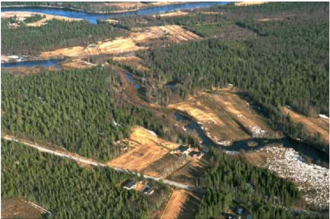
Kuva 3. Kuvan yläreunassa näkyy Simojoki ja kuvan keskellä kulkee tulvauoma, joka täyttyy keväisin vedellä.
